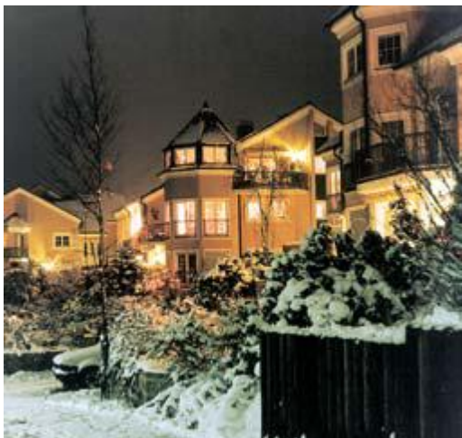
Afb. 10: Pand 3 met 12 woningen
