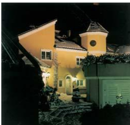
Afb. 2: Pand 1 met trappenhuistoren
