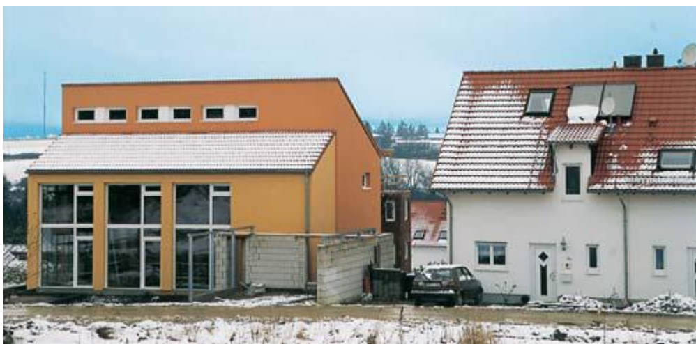
Figuur 47: Gesmolten sneeuw op een dak wijst op warmteverliezen
