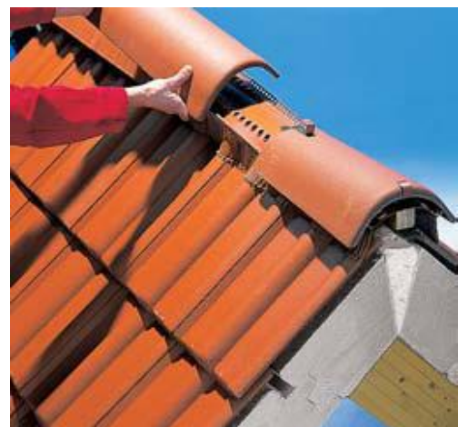
Afb. 25: Nokpannen aanbrengen
