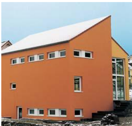
Figuur 47: Gesmolten sneeuw op een dak wijst op warmteverliezen
