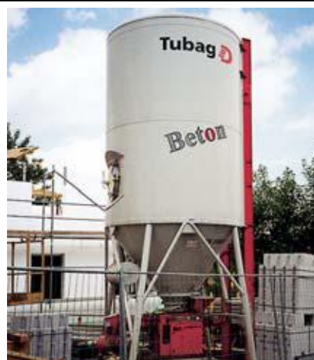
Afb. 15: Silo met droog beton
