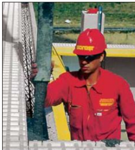
Afb. 14: Storten met transport beton
