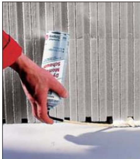
Afb. 10: Afdichten met montageschuim
