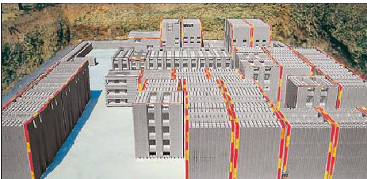
Afb. 8: Voorbeeldige bouwplaats met fixatie van de eerste rij isorast
