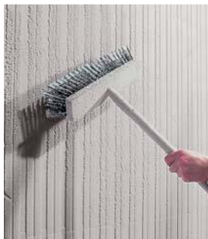
Afb. 38: Schoonvegen en opruwen met een bezem
