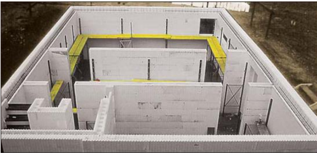
Afb. 13: Voorbeeldige, schone bouwplaats voor het storten
