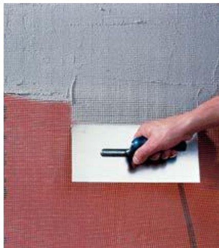
Afb. 40: voorstrijklaag pleisterwerk met weefsel
