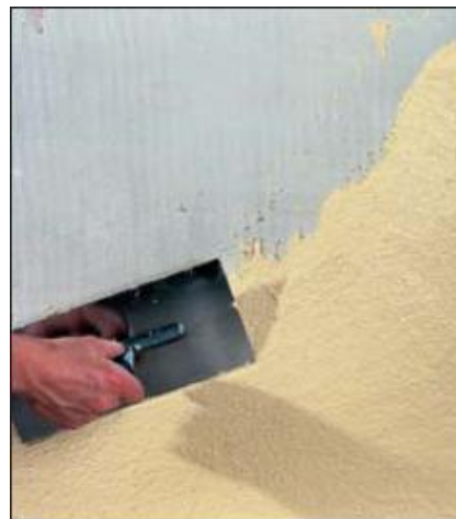
Afb. 41: Dekgips aanbrengen
