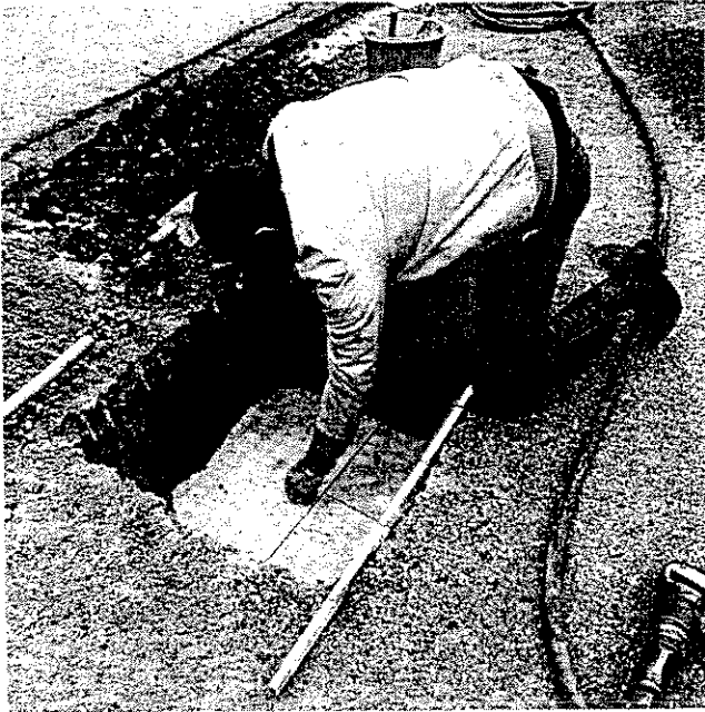
Abb. 6 Hartschaumstoffplatten aus Styropor als Frostschutzschicht im Straßenbau: Probeentnahme nach 11 Jahren Einbauzeit. Der Zustand der Hartschaumstoffplatten ist unverändert.
