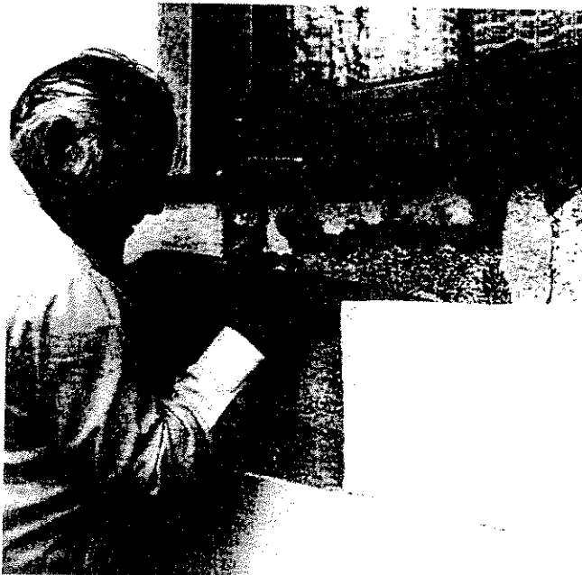
Abb. 3 Probeentnahme der Dämmschicht aus Styropor bei einem Außendämm-Verbundsystem mit gewebearmiertem Kunstharzputz.
